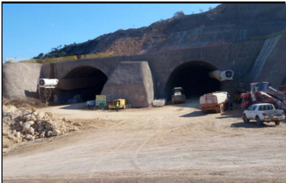
Túnel – Bocas de entrada
