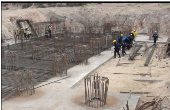
Viaducto – Pilotes y Ferrallado del Estribo 1
