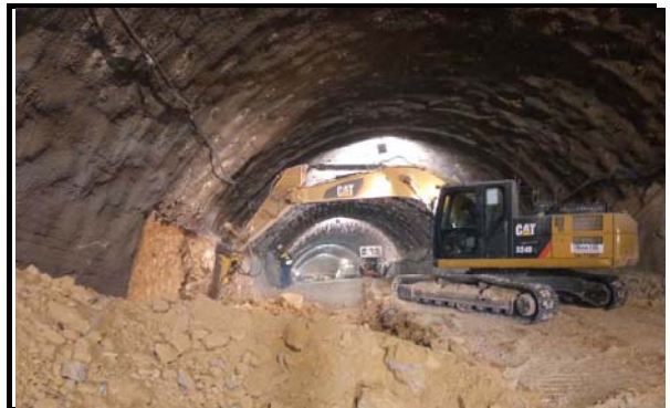
Trabajos en túnel salida izquierdo
