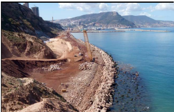
Tramo Marítimo – Colocación pie de escollera
