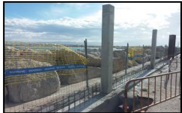
Ejecución de pilares y muro de cerramiento
