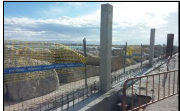
Ejecución de pilares y muro de cerramiento
