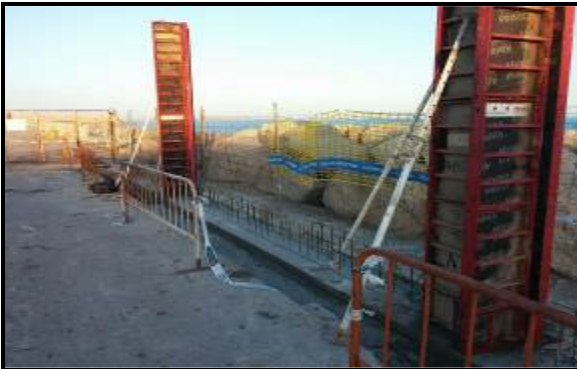
Ejecución de cimentación del muro
