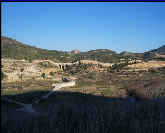
Foto Aérea: Previo a la Obra
