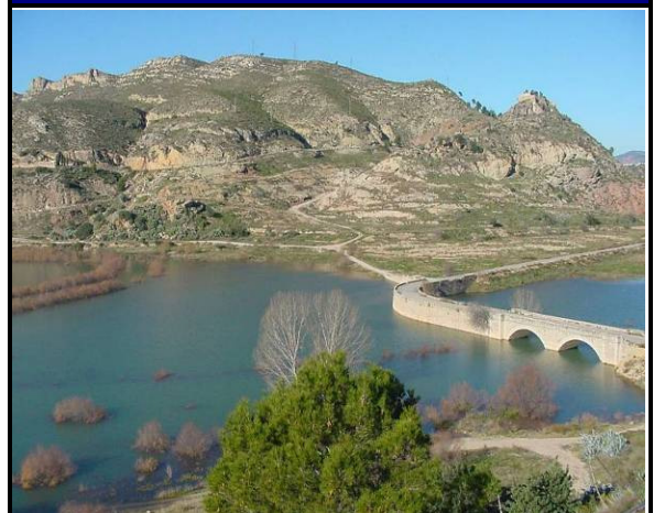
Foto Aérea: Final de Obra
