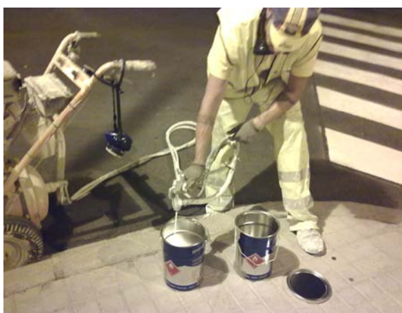
Control de calidad de la pintura empleada para la ejecución de marcas viales
