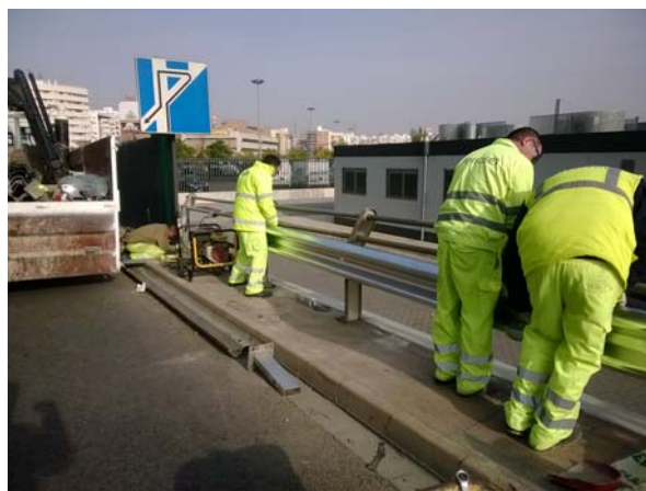
Montaje de barrera de contención
