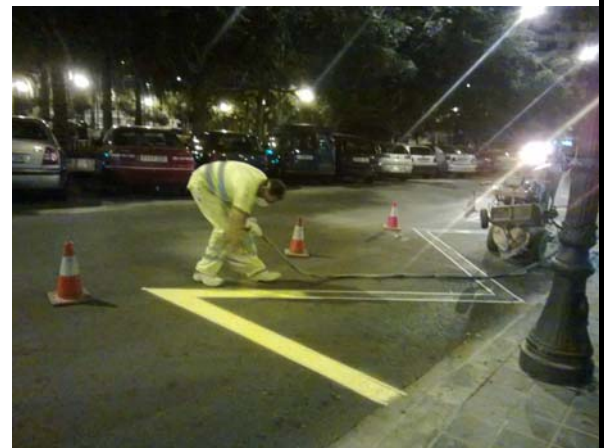
Ejecución de marcas viales
