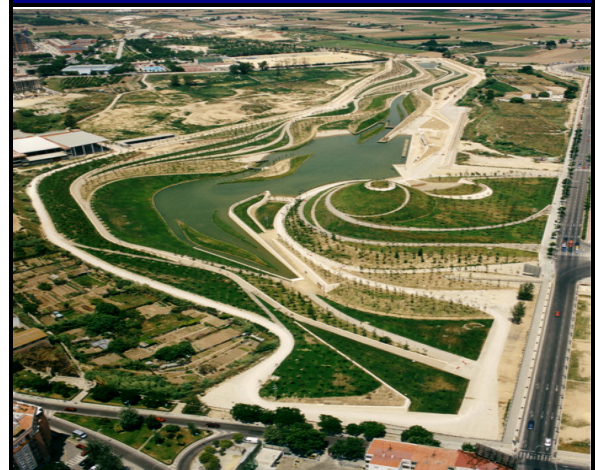
Foto Aérea: Final de Obra
