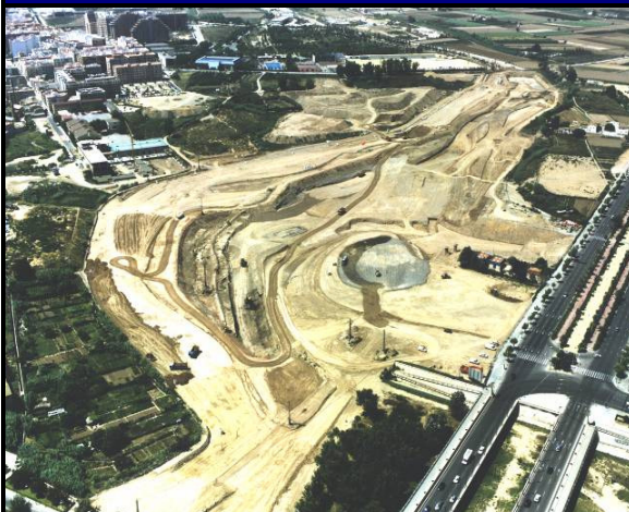
Foto Aérea: Estado Previo de la Obra
