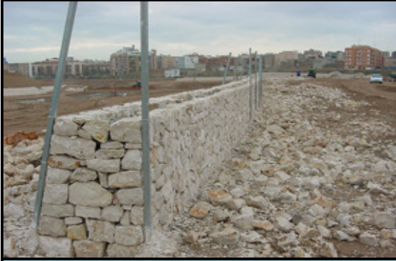
Construcción de muros de mampostería
