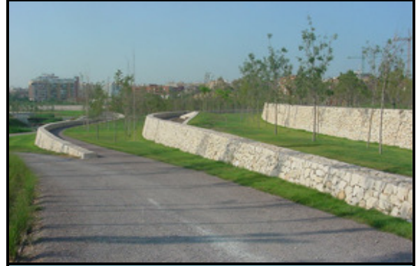
Muros de mampostería terminados
